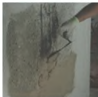
Εφαρμογή του Planitop Smooth & Repair με σπάτουλα
